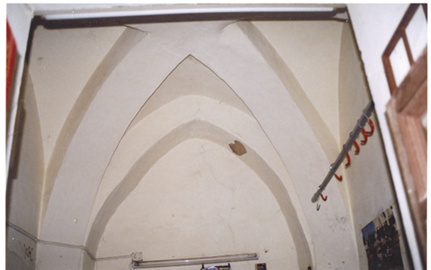
La bóveda ojival de la base de la torre.
