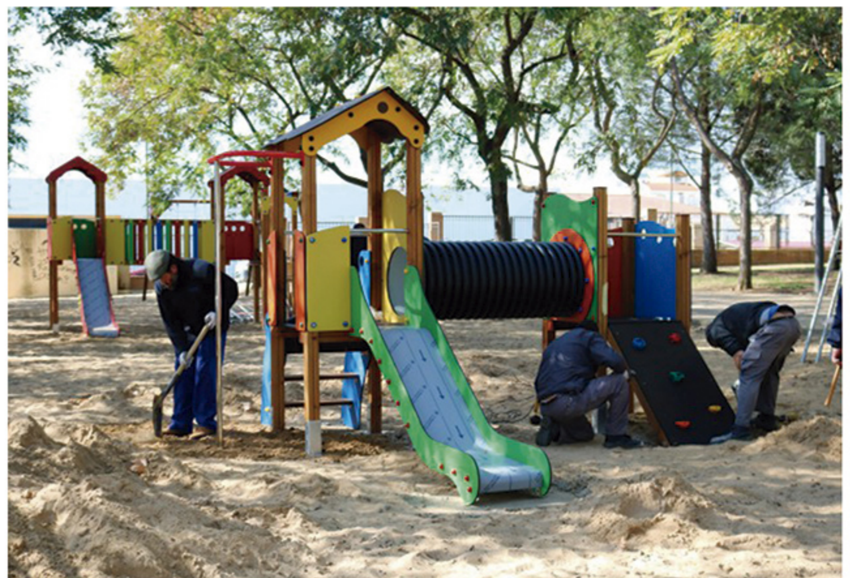
El Parque del Almendral estrenó nuevo mobiliario infantil dentro del Plan Municipal de Mantenimiento.
