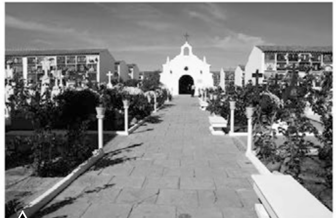
Se realizaron mejoras en el Cementerio Municipal, que incluyeron un nuevo acceso peatonal, nuevas tomas de agua, y tareas de limpieza, pintura y jardinería.
