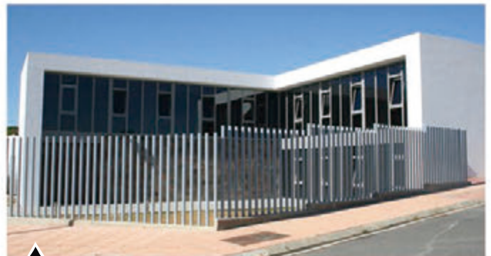
La Comunidad de Regantes inició las obras para su traslado al edificio que albergaba la Empresa Municipal del Suelo y la Vivienda, tras el acuerdo alcanzado con el Ayuntamiento.
