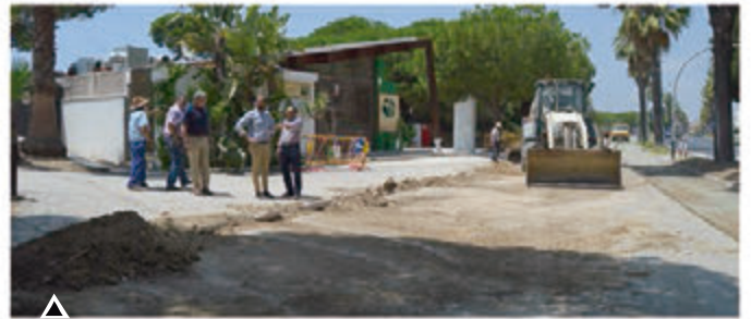
Obras municipales para dotar de suministro eléctrico el Paseo de Nuevo Portil. Consistieron en la instalación de una red de baja tensión, que ha permitido el desarrollo de actividades en este punto este mismo verano.
