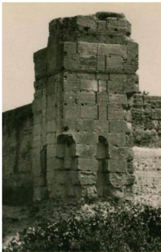
La torre del Homenaje antes de su restauración (foto M. Vázquez Galán)
