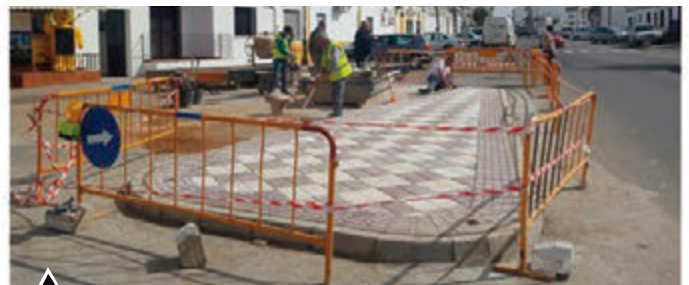
El Ayuntamiento mejora la circulación en las entradas al municipio, con obras en La Pila, y en la entrada por el Polígono La Barca.
